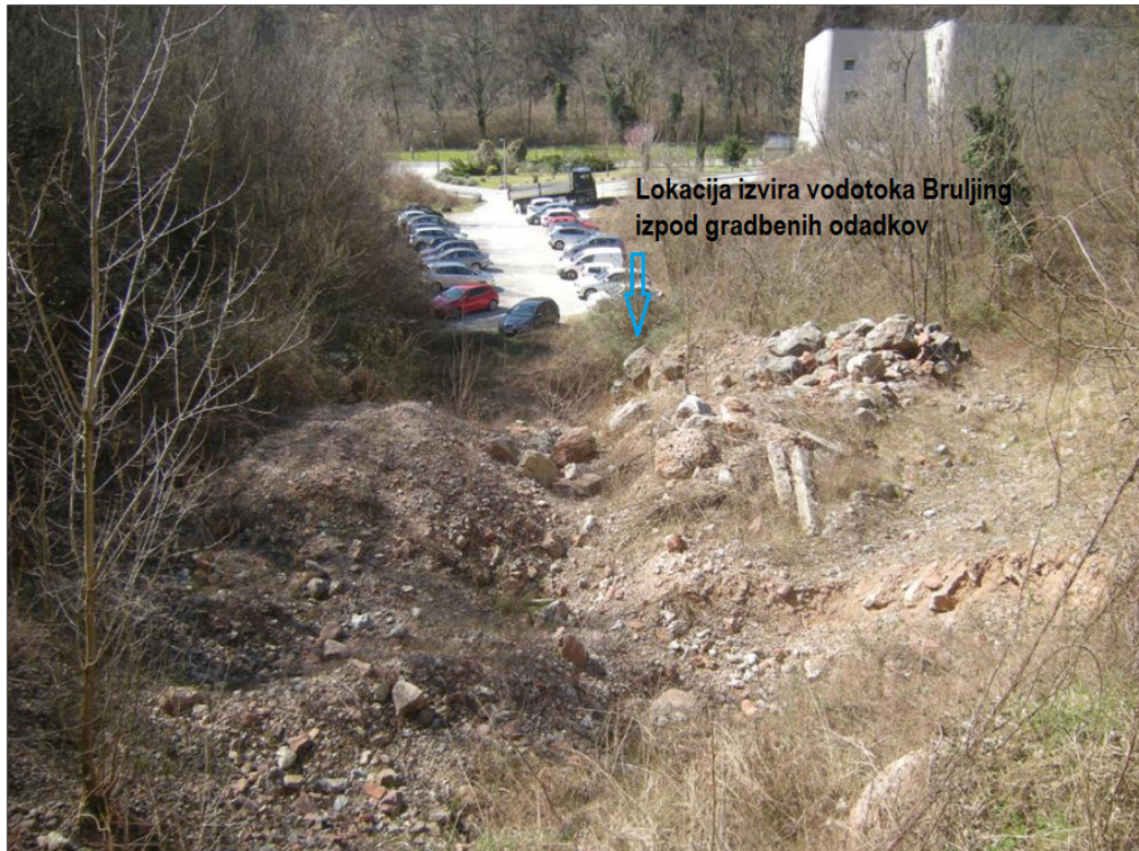
Slika 4: Nasuti material ter lokacija izvira vodotoka Bruljing izpod gradbenih odpadkov (pogled proti parkirišču v bližini doma za ostarele)
