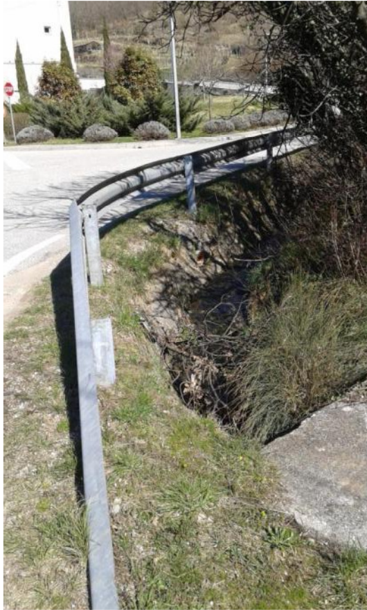
Slika 6: Vodotok Bruljing, ki teče v odprtem kanalu in iztok v cestni prepust. Pod glavno cesto do vodotoka Pevmica struga ni vidna (vkopano)
