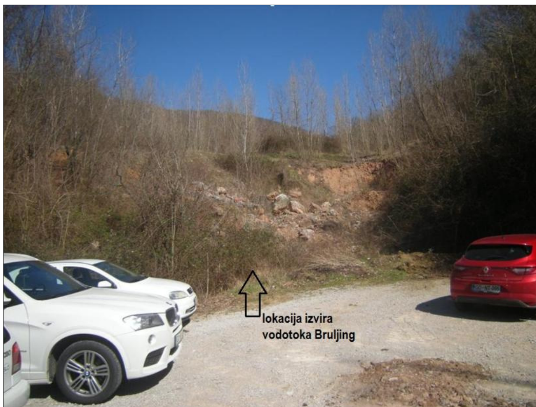
Slika 5: Nasuti material ter lokacija izvira vodotoka Bruljing izpod gradbenih odpadkov
